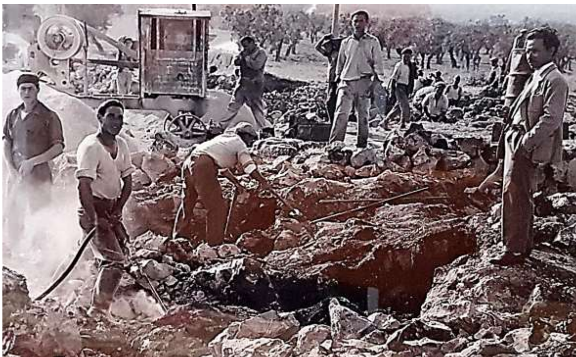
Lavori di sbancamento del piazzale AGIP a Casarano. Giovanni De Masi (primo a destra) dirige il lavoro dei suoi operai.
