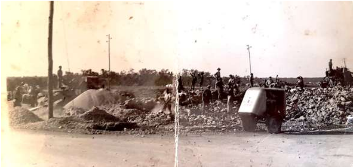
Casarano: Ditta De Masi Giovanni sul cantiere "Cava" in via Martino.
